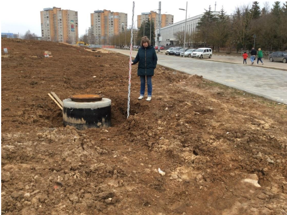
Рис. 15. Участок проведения археологических исследований на земельном участке с кадастровым номером 40:27:020201:6694 под объект: «Лекториум – инновационный центр знаний, расположенный на территории между домами 129 и 137 по пр. Ленина (ЖК «Циолковский»)». Видовая точка 6. Вид с юго-запада.
