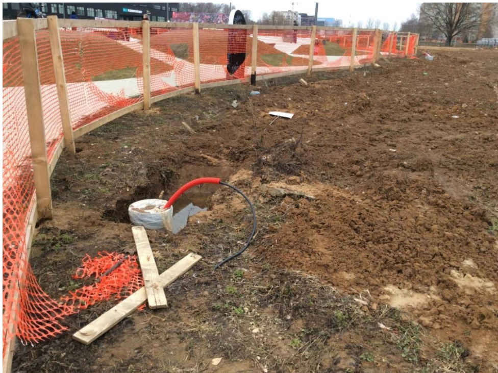
Рис. 13. Участок проведения археологических исследований на земельном участке с кадастровым номером 40:27:020201:6694 под объект: «Лекториум – инновационный центр знаний, расположенный на территории между домами 129 и 137 по пр. Ленина (ЖК «Циолковский»)». Видовая точка 4. Вид с юго-запада.
